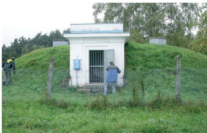
Šetření na jednom ze zemních vodojemů
