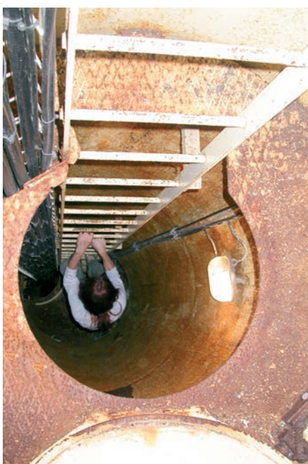
Prohlídka věžového vodojemu
