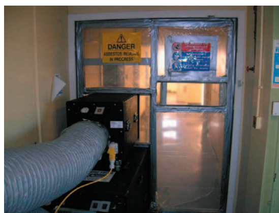
Obrázek 12.2: Podtlakové jednotky a potrubí pro odvod vzduchu, průzory a výstražné značení.
