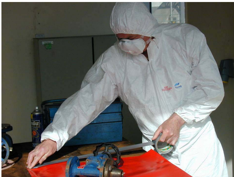
Obrázek 11.3: Ochrana pracovní plochy pomocí pásky a polyethylenové fólie před odstraňováním azbestového těsnění z ventilu.
