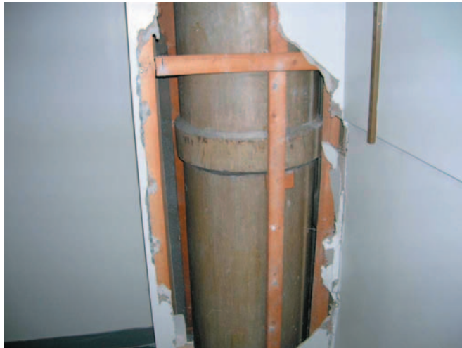
Obrázek 4.2: Azbestocementová kouřová trubka, která je vidět pod částečně odstraněným pláštěm z azbestové izolační desky.
