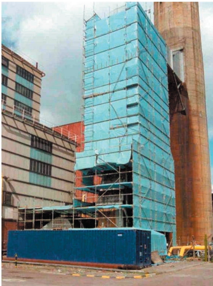
Obrázek 12.3: Uzavřený prostor pro odstranění tepelné izolace z potrubí pro odvod spalin.
