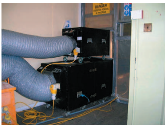
Obrázek 12.2: Podtlakové jednotky a potrubí pro odvod vzduchu, průzory a výstražné značení.
