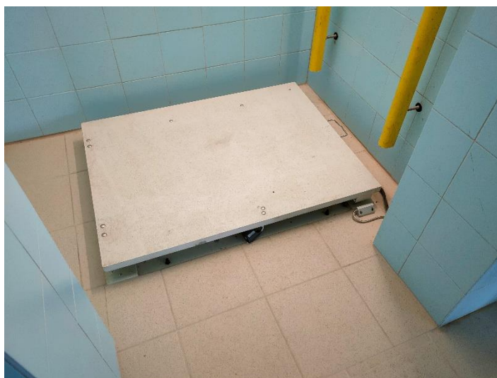
Obr. 7-5. Příklad dobré praxe řešení vstupu do akumulční nádrže vodojemu z armaturní komory: práh i poklop jsou zhotoveny z nerezavějícího kompozitního materiálu, kolem vstupu je neprášivá omyvatelná dlažba, vzduchotěsné těsnění vstupního otvoru, elektronická detekce otevření poklopu s přenosem na centrální pult, visací zámek, vyvýšený práh kolem otvoru. Foto: Jan Ručka, VUT Brno.
